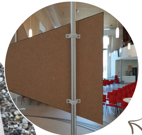
Foto b: constructie met klemmetjes om de pijlen op het paaltje te schuiven
